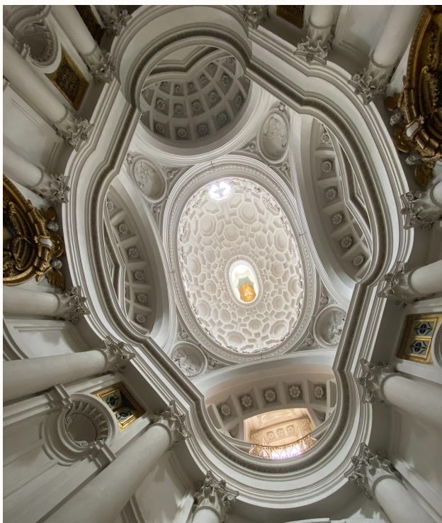
Soffitto della Chiesa di San Carlino alle Quattro fontane
